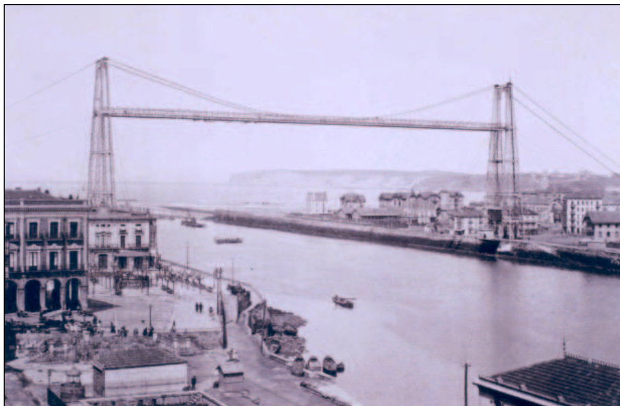
Fig. 2. El Puente Vizcaya en 1894, al año siguiente de su inauguración, uniendo las poblaciones balnearias de Portugalete y Las Arenas. Foto Hauser y Menet.
