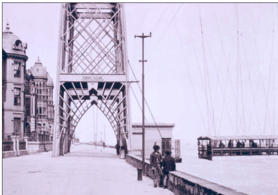
Fig. 6. Base de las torres del Puente Vizcaya y estación de embarque en el muelle de Portugalete. Foto Hauser y Menet.
