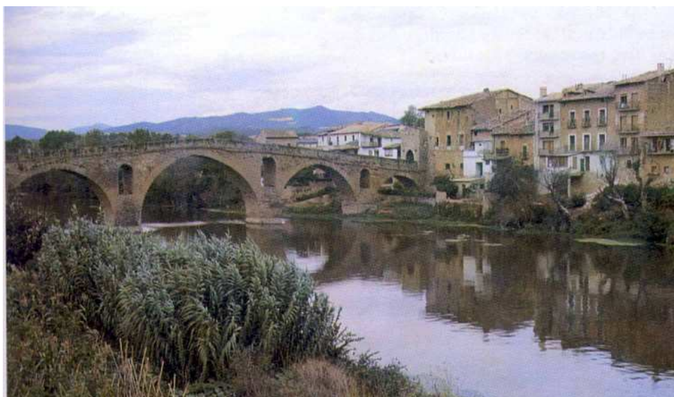
Puente la Reina (Navarra).
