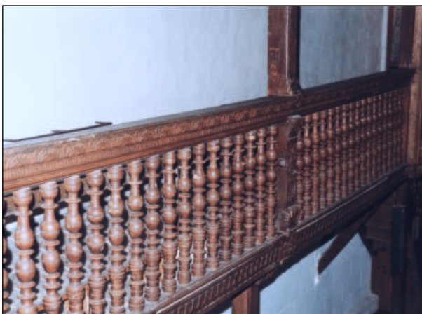
6. Louhossoa: Sainte-Marie, galerie sur consoles.
