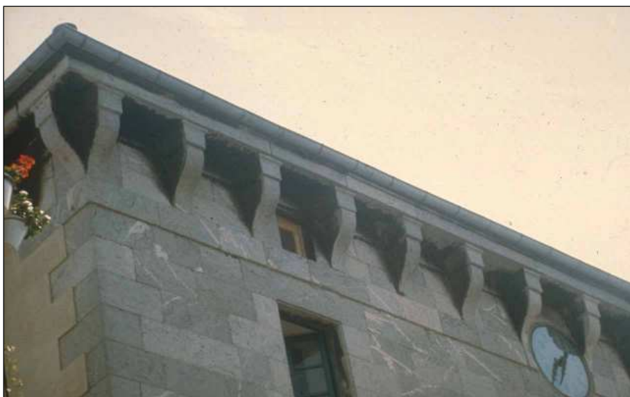
Detalle de la cornisa del antiguo consistorio de Ondarroa.
