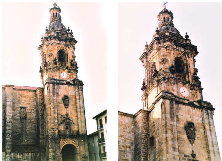
Torre de la Parroquia de San Salvador, Usurbil
