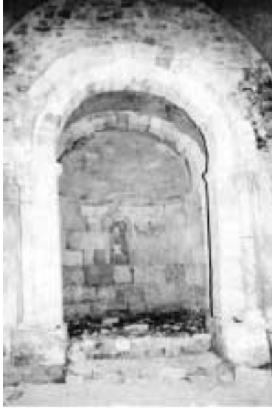
Interior de la Ermita de San Juan de Cárcamo.
