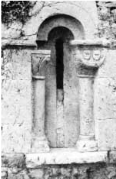
Ventanal exterior del ábside de Astúlez.
